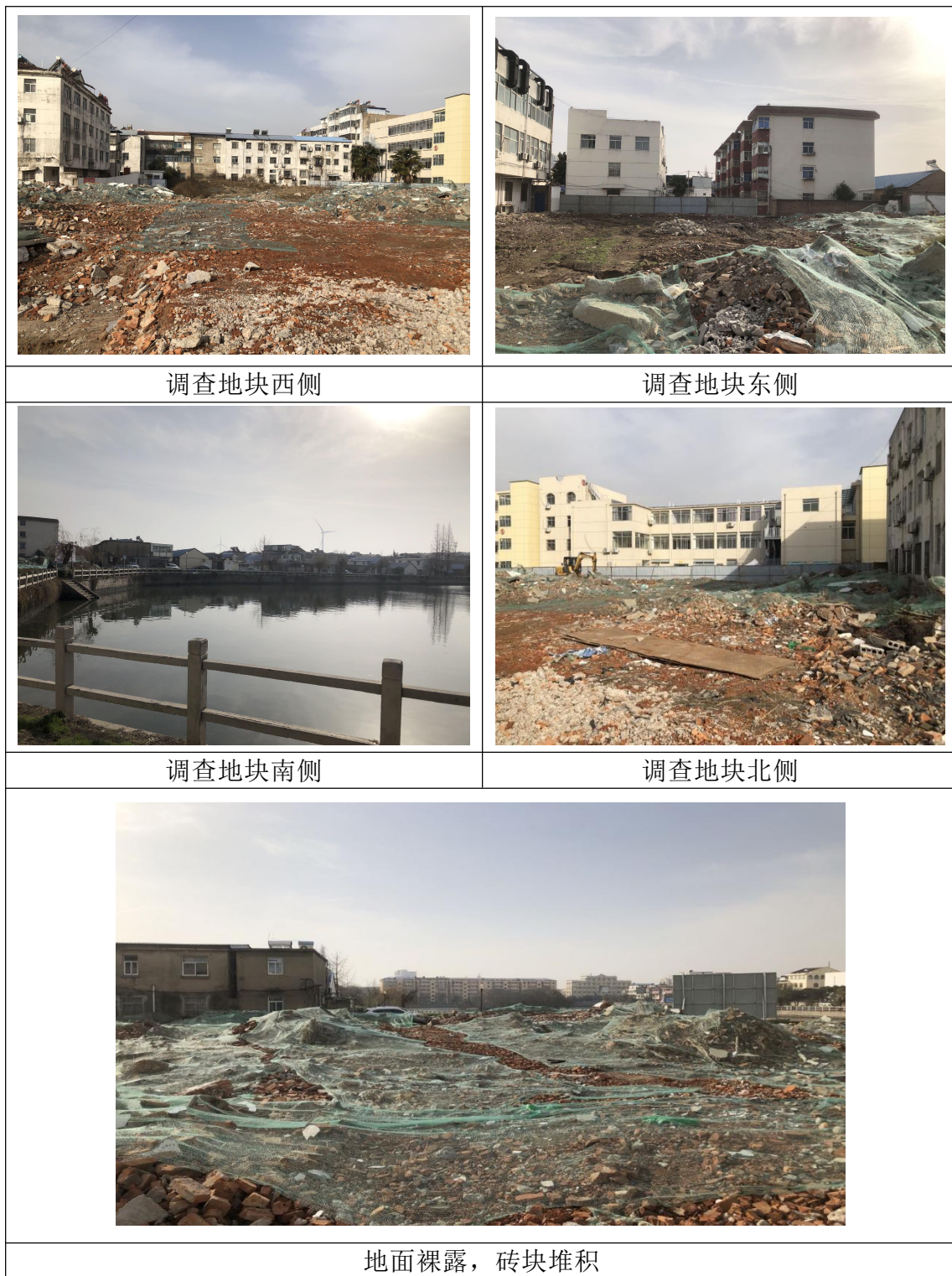
图5. 1-2 调查地块内现场踏勘图片
