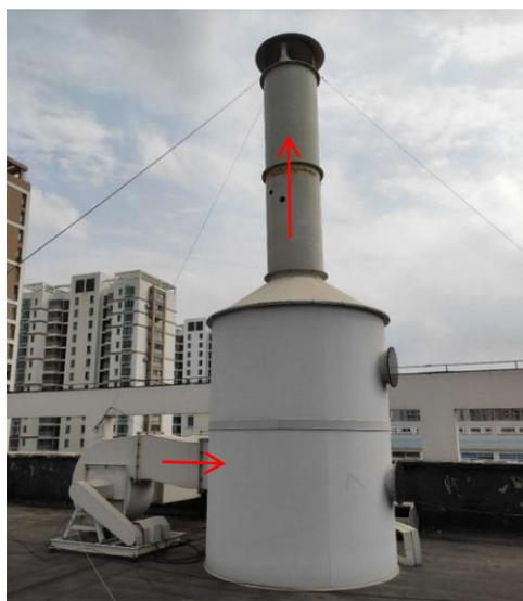
水喷淋废气处理装置
